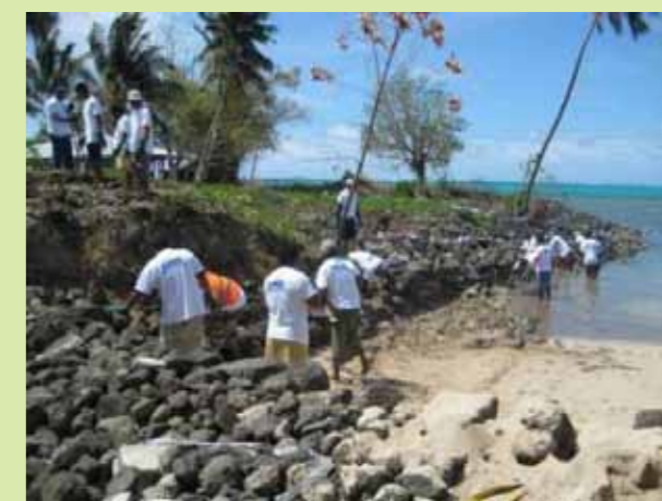
Samoa. Ricostruzione del muro di contenimento su Manono Island, Dic.2009
